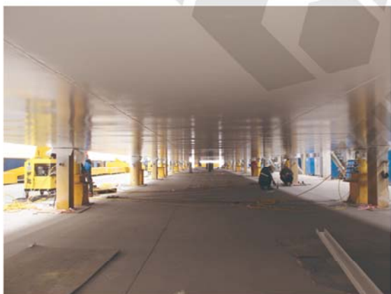
● 大型构件同步顶升称重
