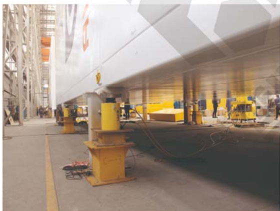
● 大型构件同步顶升称重
