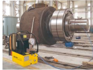
● 水泥厂磨辊机维修轴承安装
