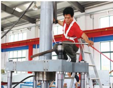
● 大型压机螺栓预紧
