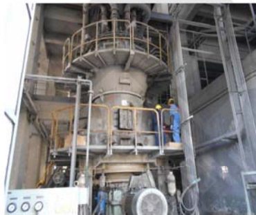
● 水泥厂立磨地脚螺栓预紧
