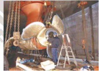
● 造船厂螺旋桨安装
