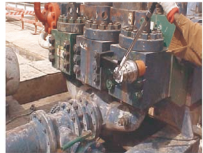
● 石油管道阀门螺栓预紧
