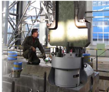
● 16000吨压机组装螺栓拉伸预紧
