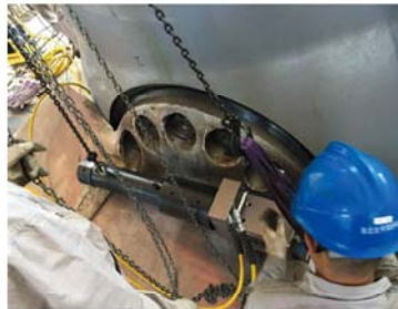
● 水轮机叶片螺栓预紧
