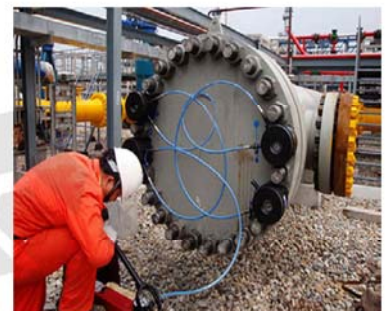
● 炼油厂压力容器螺栓同步拉伸预紧
