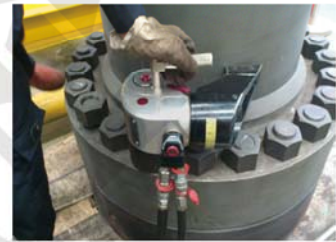
● 化工厂高压管道法兰盘螺栓预紧
