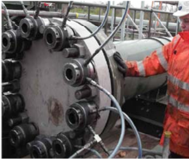
● 管道法兰盘螺栓同步拉伸预紧
