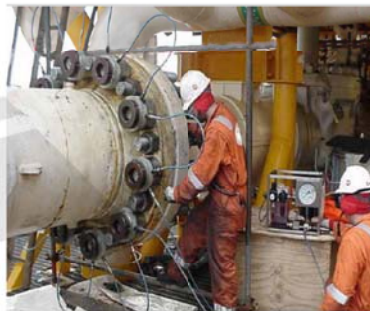
● 钢厂压力容器螺栓同步拉伸预紧
