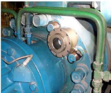
● 火力发电厂大型电机螺栓预紧
