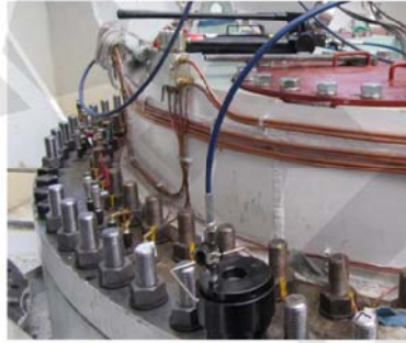
● 大型设备螺栓同步拉伸预紧
