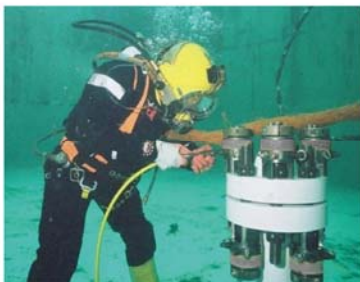
● 海底管道阀门同步拉伸预紧
