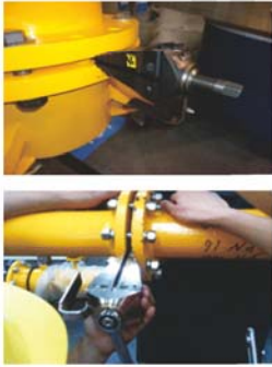
● 炼油厂管道法兰分离更换盘根
