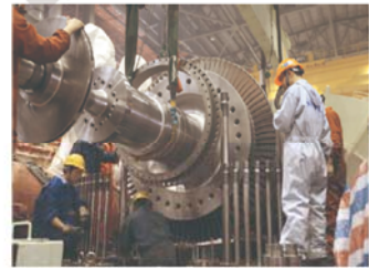
● 火力发电厂汽轮机维修螺栓拆卸
