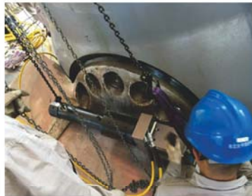
● 水轮机叶片螺栓预紧
