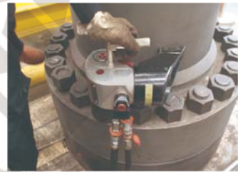
● 化工厂高压管道法兰盘螺栓预紧
