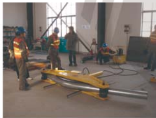
● 核电站电缆管道的弯制
