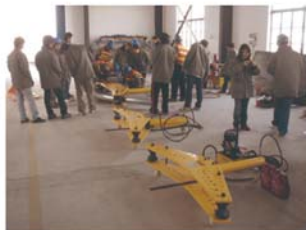
● 核电站电缆管道的弯制
