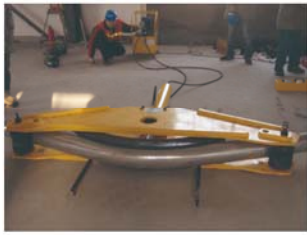
● 核电站电缆管道的弯制
