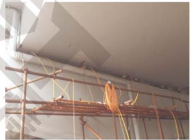
● 桥梁维修同步顶升更换橡胶支座
