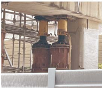
● 桥梁整体同步顶升抬高
