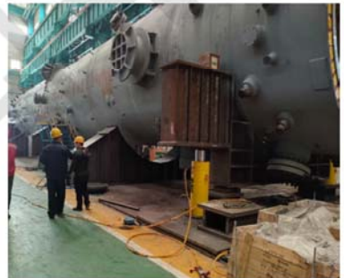
● 大型压力容器同步顶升移运
