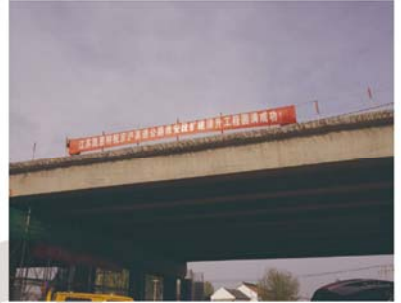
● 京沪高速维修同步顶升更换橡胶支座
