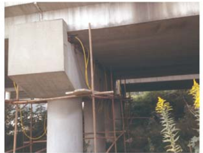
● 沪宁高速维修同步顶升更换橡胶支座
