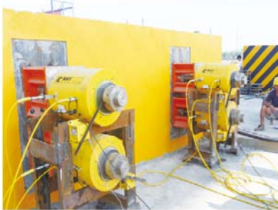
● 混凝土箱梁预制同步张拉
