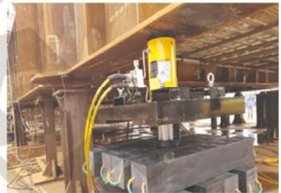
● 钻井平台模块同步分级顶升称重
