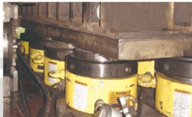
● 桥梁维修同步顶升更换橡胶支座
