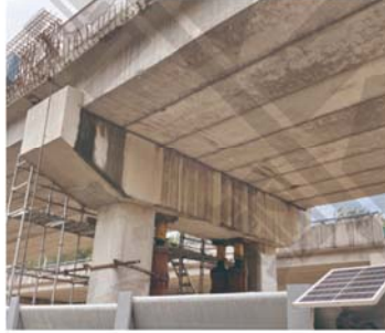
● 桥梁整体同步顶升抬高
