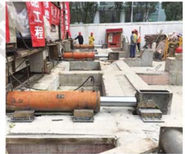
● 古建筑整体同步顶升平移
