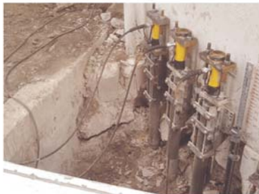
● 建筑物同步顶升纠偏
