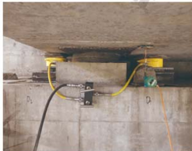
● 桥梁维修同步顶升更换橡胶支座
