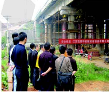
● 桥梁同步顶升更换橡胶支座
