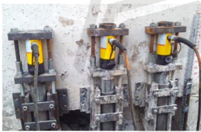
● 建筑物纠偏顶升
