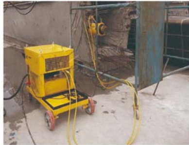
● 混凝土箱梁预制同步张拉
