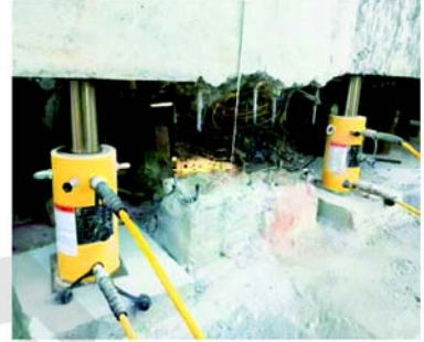
● 房屋同步顶升纠偏平移
