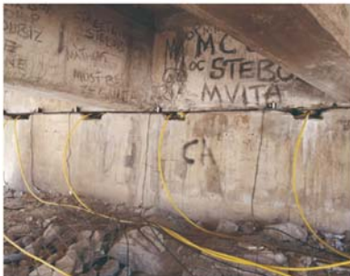
● 桥梁维修同步顶升更换橡胶支座
