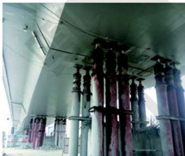
● 桥梁调坡同步顶升对接
