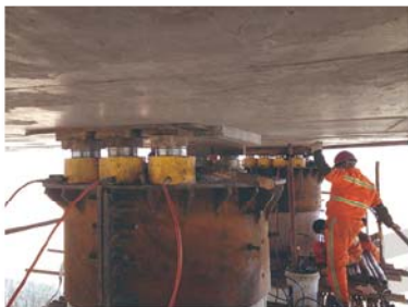
● 桥梁维修同步顶升更换橡胶支座
