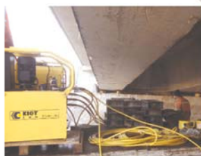
● 桥梁维修同步顶升更换橡胶支座
