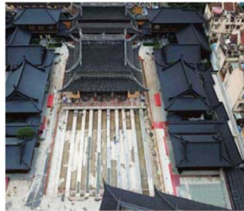
● 古建筑整体同步顶升平移
