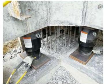
● 建筑物同步顶升纠偏
