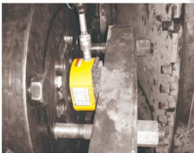
● 水泥厂减速机维修解体应用
