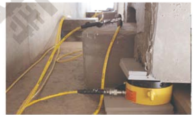
● 桥梁维修同步顶升更换橡胶支座
