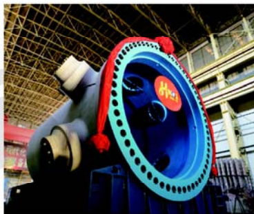
● 核反应堆压力容器同步顶升安装
