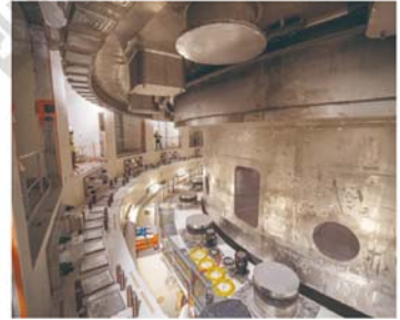
● 核聚变杜瓦底座同步顶升安装
