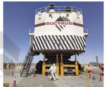
● 大型设备同步顶升检修
