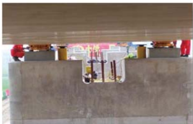
● 桥梁维修同步顶升更换橡胶支座
