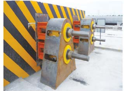
● 混凝土箱梁预制同步张拉
