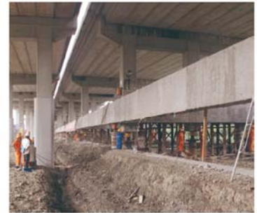
● 大型桥梁整体同步顶升抬高
