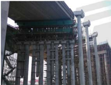
● 桥梁抬高长期支撑
