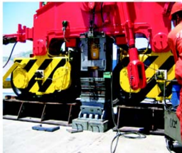
● 500T 港口浮吊维修同步顶升
