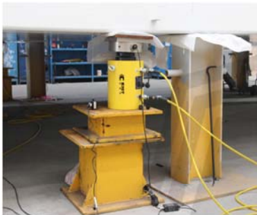
● 大型钢构同步顶升称重
