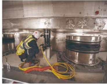
● 核聚变杜瓦底座同步顶升安装
