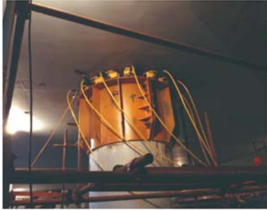
● 桥梁维修同步顶升更换橡胶支座
