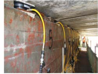
● 桥梁维修同步顶升更换橡胶支座
