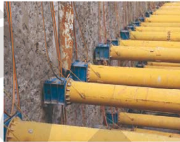
● 地铁建设轴力加载支撑
