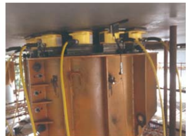
● 桥梁维修同步顶升更换橡胶支座
