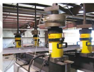
体育馆钢结构组裝同步提升
