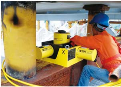
● 钢箱梁同步顶升精调
