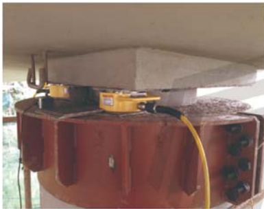
● 桥梁维修同步顶升更换橡胶支座
