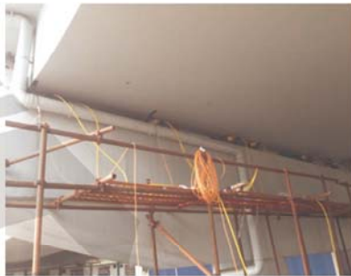
● 桥梁维修同步顶升更换橡胶支座
