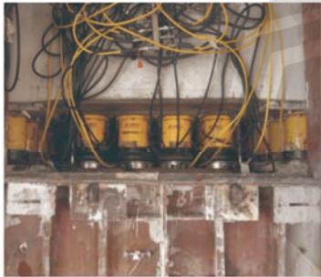
● 大型桥梁交替顶升
