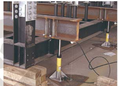
● 大型钢构同步顶升安装
