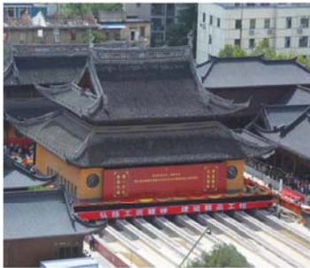
● 古建筑整体同步顶升平移
