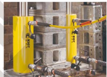
● 建筑物同步顶升纠偏
