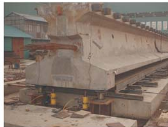
● 磁悬浮轨道建设同步顶升精调
