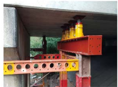
● 桥梁维修同步顶升更换橡胶支座
