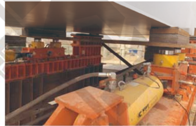
● 桥梁建设钢箱梁同步顶推
