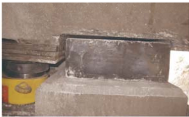
● 桥梁维修同步顶升更换橡胶支座
