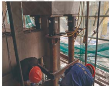
● 房屋加固混凝土支墩托换
