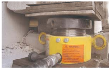
● 桥梁维修同步顶升更换橡胶支座
