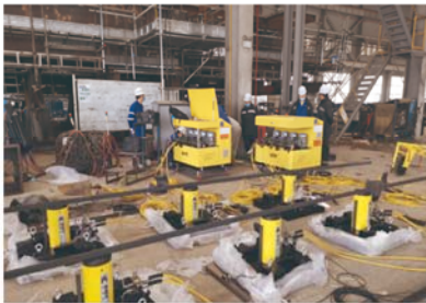
● 钻井平台模块同步分级顶升称重
