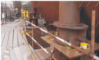
● 核岛穹顶同步顶升就位
