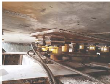
● 桥梁维修同步顶升更换橡胶支座
