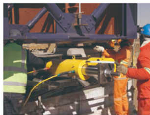
● 桥梁建设钢结构同步牵引
