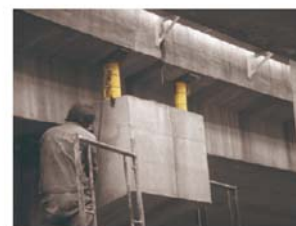
● 桥梁维修同步顶升更换橡胶支座
