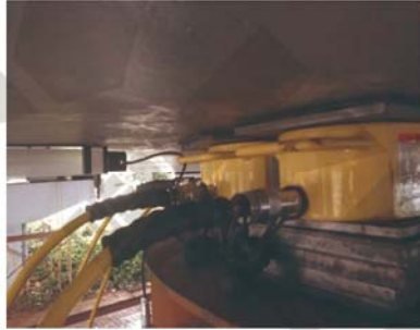
● 桥梁维修同步顶升更换橡胶支座
