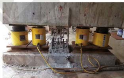
● 高速公路桥梁交替同步顶升
