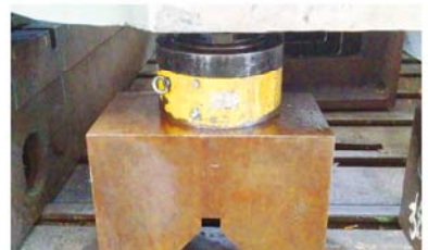
● 万吨压机安装长期支撑
