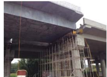
● 桥梁维修同步顶升落梁
