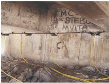
● 桥梁维修同步顶升更换橡胶支座
