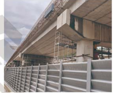
● 桥梁整体同步顶升抬高
