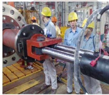
● 大型电机检修
