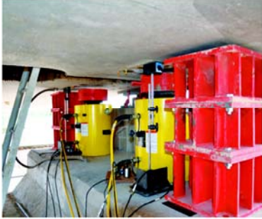
● 高铁桥梁沉降整治同步顶升
