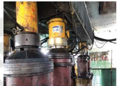
● 桥梁抬高长期支撑
