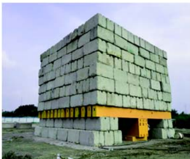
● 高层建筑桩基静载实验
