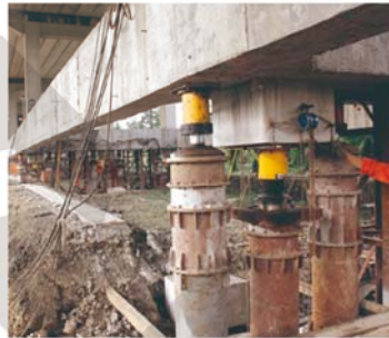
● 大型桥梁整体同步顶升抬高
