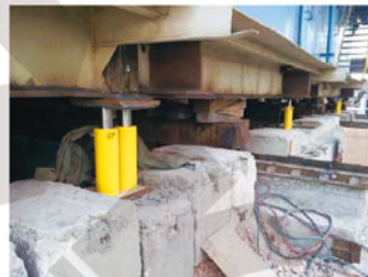
● 钢厂高炉更换同步顶升
