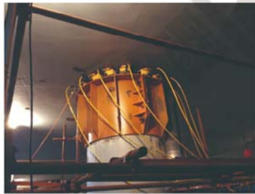
● 桥梁维修同步顶升更换橡胶支座
