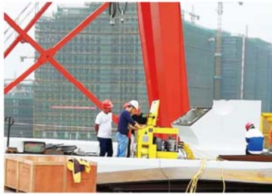
● 钢箱梁同步顶升精调
