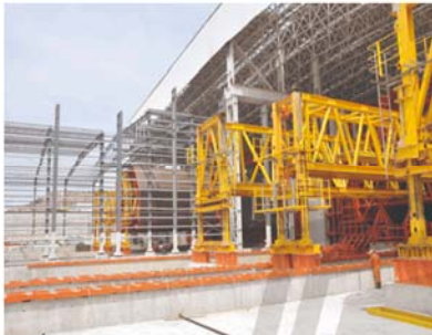
● 海底隧道建设沉箱同步顶推就位
