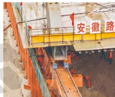
● 桥梁建设同步顶推
