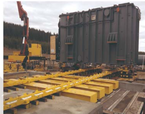
● 变压器同步顶推就位
