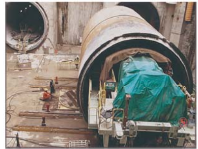
● 盾构机同步推移就位
