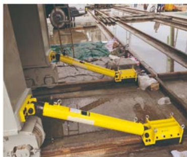
● 变压器同步推移就位
