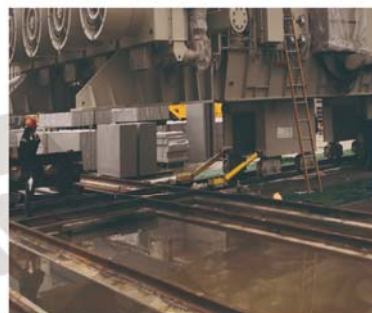
● 变压器同步推移就位
