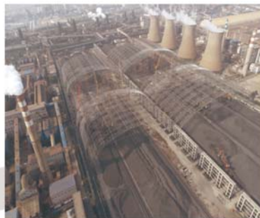
● 钢厂储煤场钢构屋顶同步推移安装
