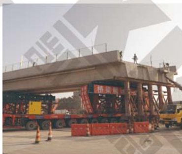
● 新旧桥梁快速拆装
