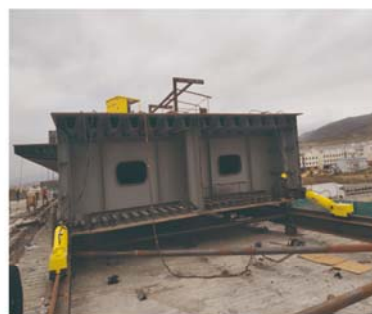
● 钢箱梁同步顶推就位
