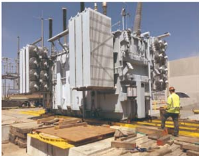
● 大型变压器同步推移就位
