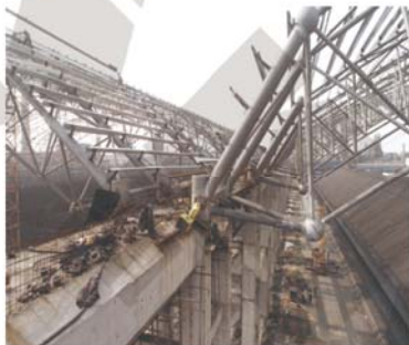
● 钢厂储煤场钢构屋顶同步推移安装
