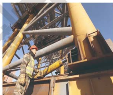
● 屋面环桁架同步顶推滑移
