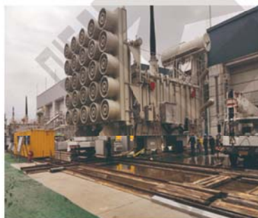
● 变压器同步推移就位
