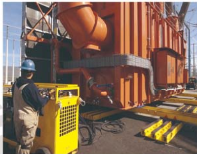
● 大型变压器同步推移就位
