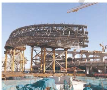
● 屋面环桁架同步顶推滑移
