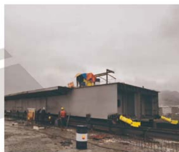
● 钢箱梁同步顶推就位
