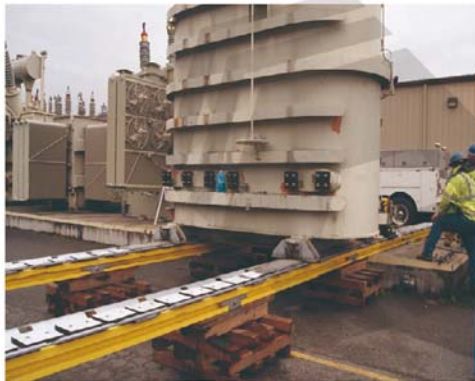
● 变压器同步顶推就位
