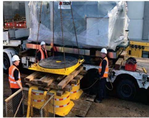
● 变压器同步顶推就位
