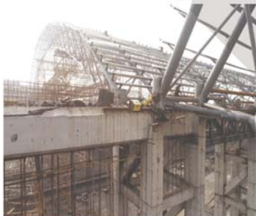
● 钢厂储煤场钢构屋顶同步推移安装
