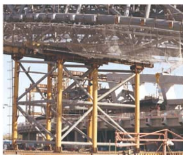
● 屋面环桁架同步顶推滑移
