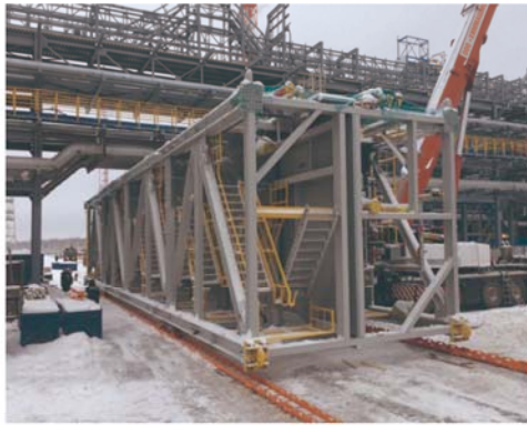
● 石化管道模块同步顶推就位
