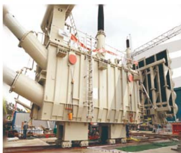
● 变压器同步推移就位
