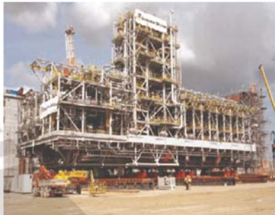
● 液化石油气再气化装置同步顶推就位
