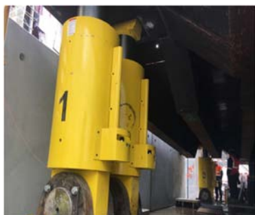
● 盾构机始挖平台同步顶升姿态调整
