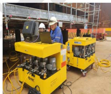
● 海洋钻井平台分级顶升
