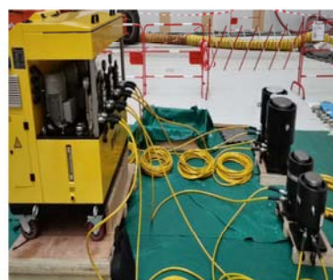
● 核聚变杜瓦底座同步顶升安装
