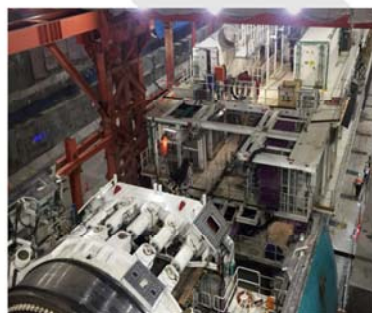
● 盾构机始挖平台同步顶升姿态调整
