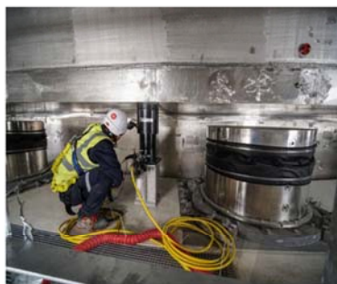
● 核聚变杜瓦底座同步顶升安装
