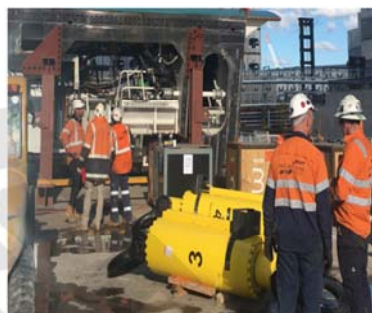
● 盾构机始挖平台同步顶升姿态调整
