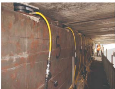
● 24点抬高同步顶升更换橡胶支座
