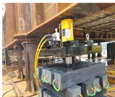
● 海洋钻井平台分级顶升
