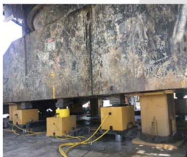
● 大型电铲同步顶升检修
