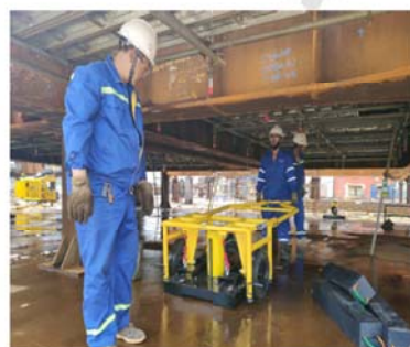
● 海洋钻井平台分级顶升
