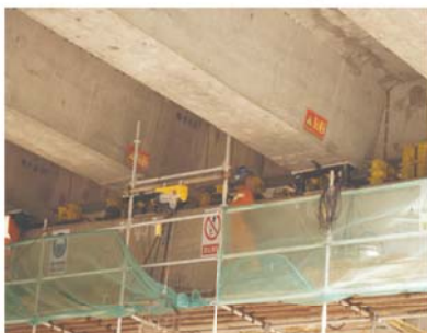
● 高速公路桥梁同步顶升更换橡胶支座
