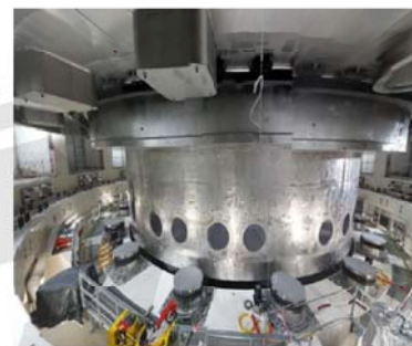
● 核聚变杜瓦底座同步顶升安装
