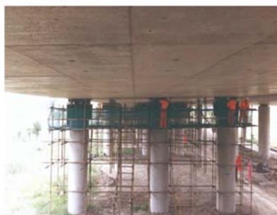
● 桥梁同步顶升更换橡胶支座
