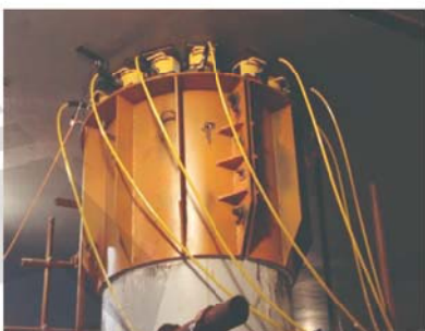
● 高架桥同步顶升更换箱梁盆式支座
