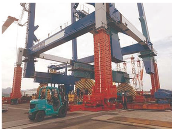
● 门式起重机同步顶升检修
