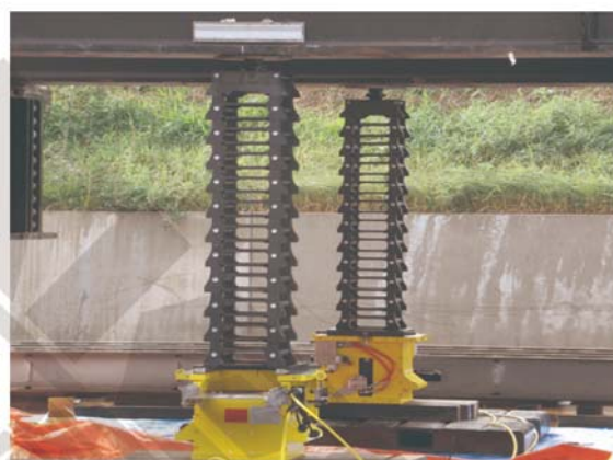
● 大型钢构同步顶升就位
