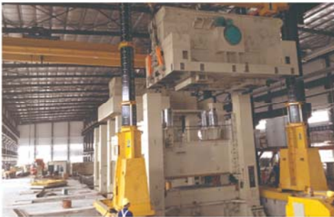
● 大型锻压机提升安装
