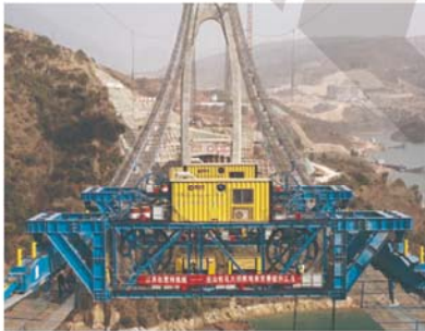
● 悬索桥钢箱梁同步提升吊装
