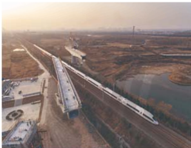
● 高铁桥梁转体工程
