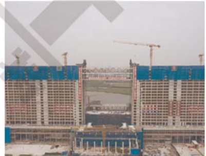
● 高空大跨度钢结构廊桥整体同步提升
