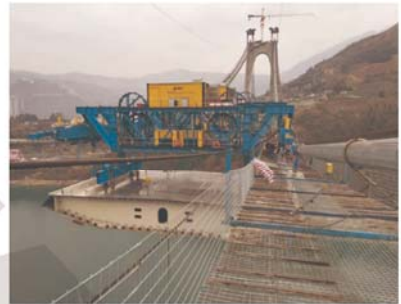
● 悬索桥钢箱梁同步提升吊装
