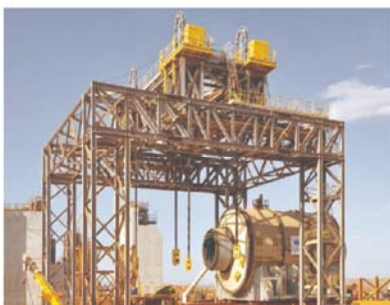
● 球磨机同步提升安装
