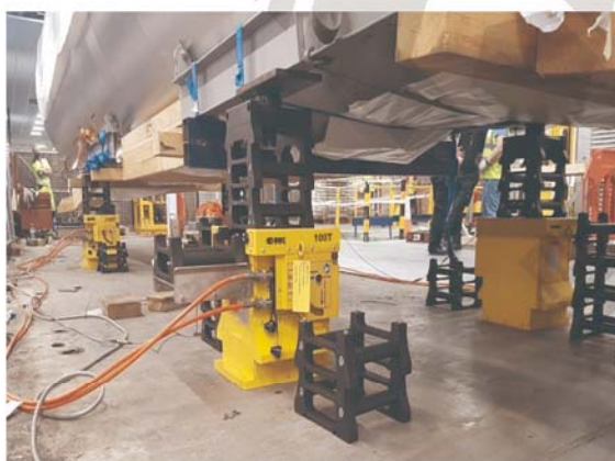
● 大型设备组装同步顶升就位
