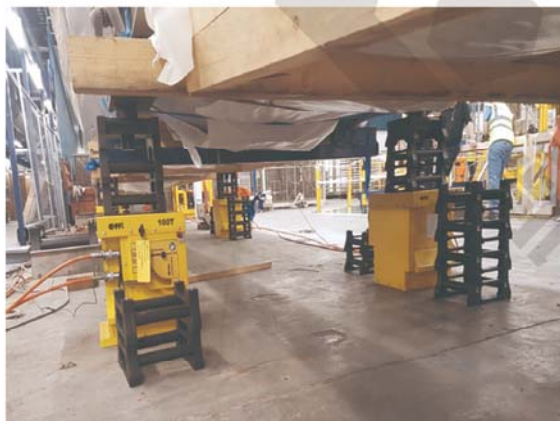
● 大型设备组装同步顶升就位
