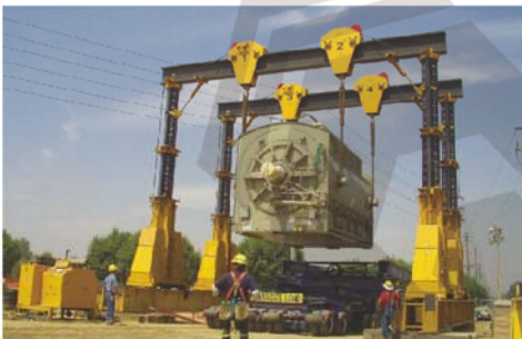
● 大型发电机提升安装
