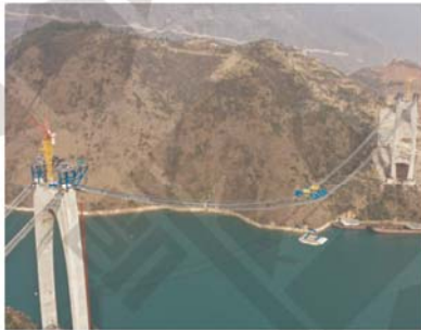
● 悬索桥钢箱梁同步提升吊装
