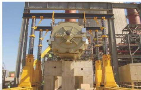
● 大型发电机提升安装
