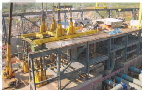
● 大型发电机提升安装
