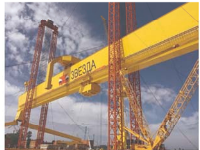
● 600T 龙门吊同步提升安装
