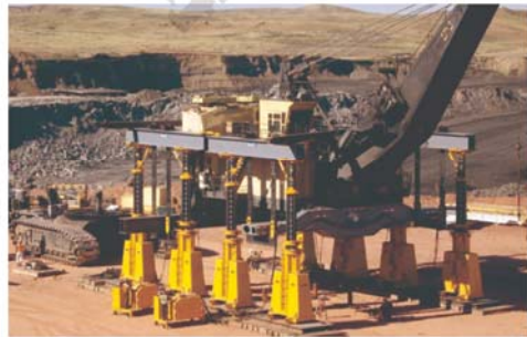
● 大型电铲顶升维修
