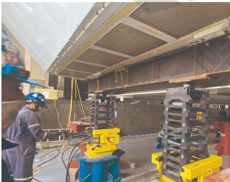
● 大型设备组装同步顶升就位
