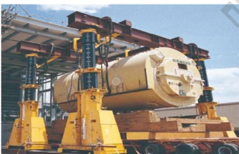
● 大型发电机提升安装
