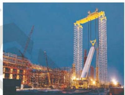
● 加氢裂化器同步提升安装
