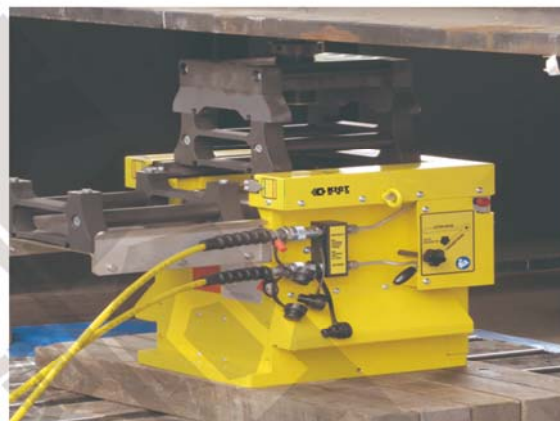
● 大型钢构同步顶升就位
