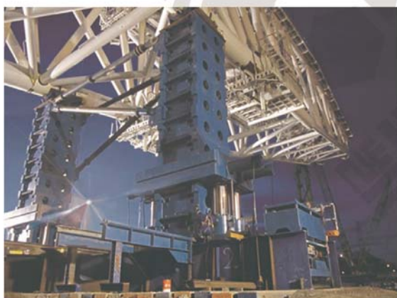
● 钢结构桥梁同步顶升安装
