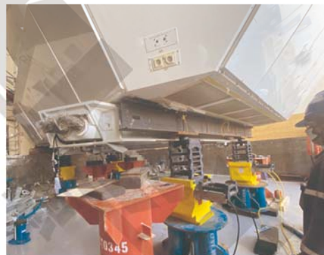
● 大型设备组装同步顶升就位
