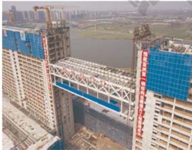
● 高空大跨度钢结构廊桥整体同步提升
