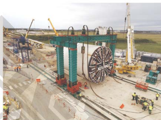
● 盾构机同步顶升就位
